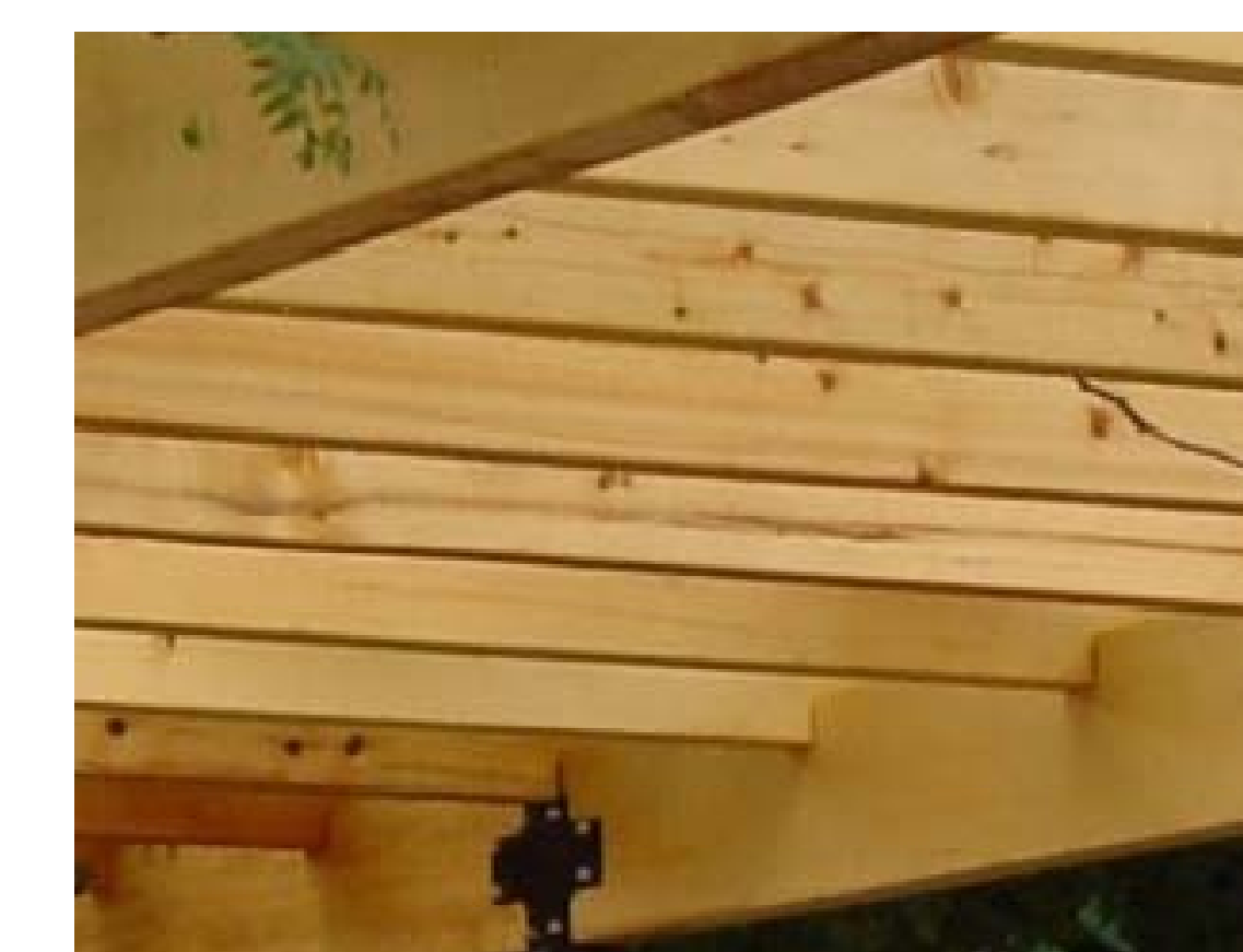
E. Alaskan yellow cedar beams & trellis
